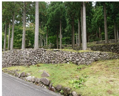
<現存する石垣>
