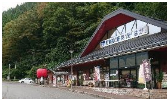
<道の駅はがの外観>
