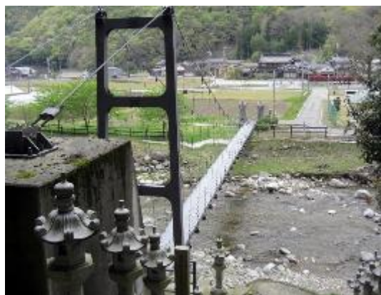
<吊り橋 (奥の院側より) >
